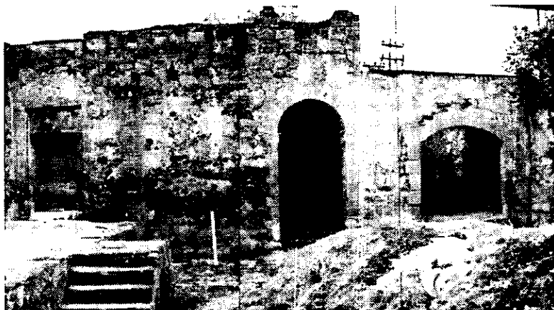
Fig. 52 Fachada sur del patio de entrada.
