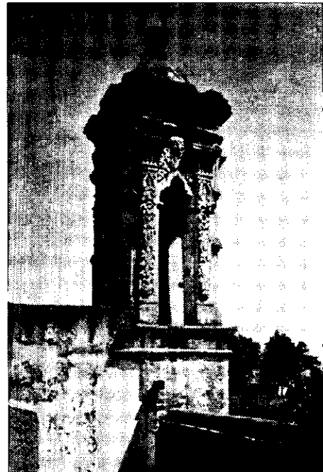
Fig. 38 Campanario con ornamentación en argamasa. Fotografía antigua
