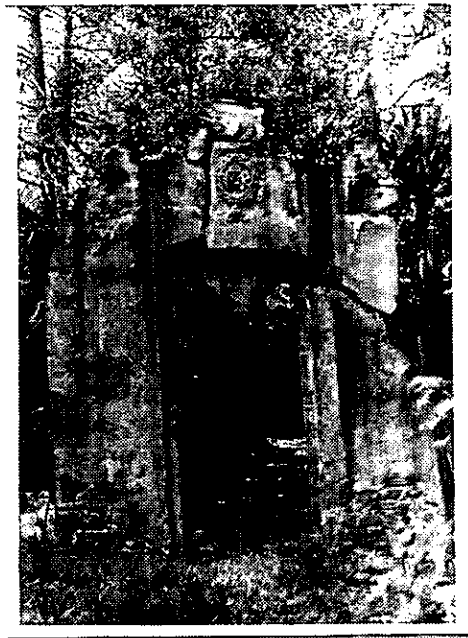
Fig. 48 Detalle de argamasa en la parte posterior de una portada. Fotografía antigua.
