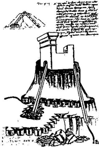
**Figura 3.1** Sifón. Ilustración tomada del libro de Enzo Levi<sup>13</sup>. Tomada de un tratado de Mariano Taccola(1381-1458), muestra como se creía que se podía elevar el agua a cualquier altura utilizando un sifón.
