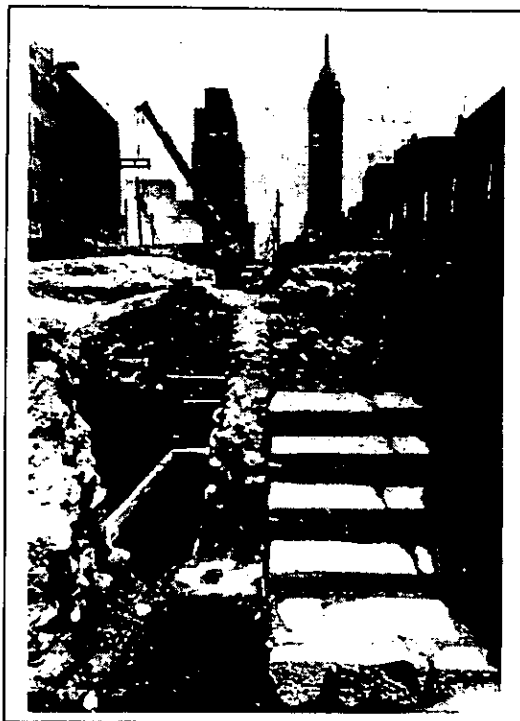
Excavaciones en el Eje Central "Lázaro Cárdenas" para la construcción de la Línea No. 10 del Metro. Hallazgo de obras coloniales y precolombinas. Década de los años ochenta. Foto: cortesía del periódico Excélsior.
