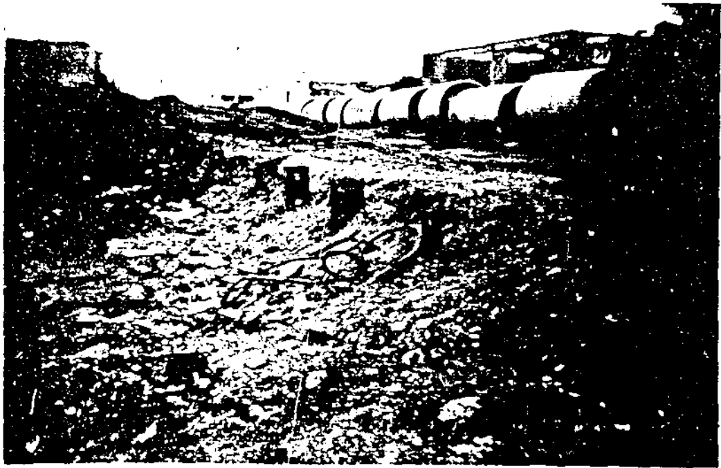
FOTO No. 16 REFORZAMIENTO PERIMETRAL CON VIGUETA Y FANTALLA METALICA EN ZONA PARA CONSTRUIR PLANTA DE BOMBEO SOBRE SURTI- DOR
