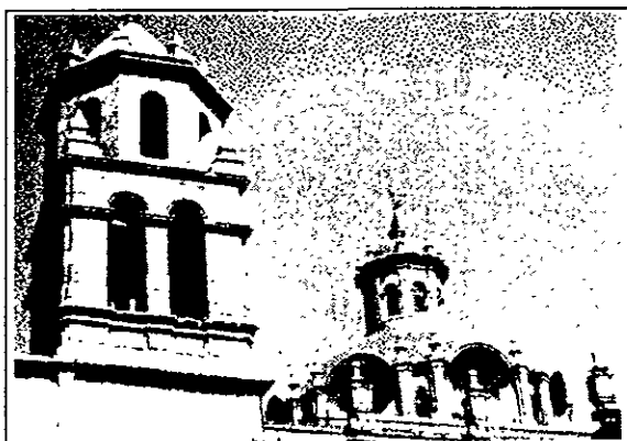
Fotografía 6. Detalle de la torre del templo y a la derecha la cúpula que cubre el cubo de escalera en el claustro.
