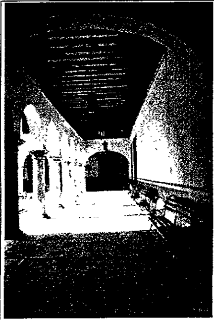
Fotografía 8. Vista del corredor norte en el claustro bajo.
