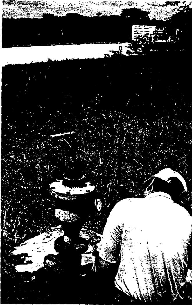
**FOTOGRAFÍA 8.** Manómetro instalado en una válvula de admisión y expulsión de aire
