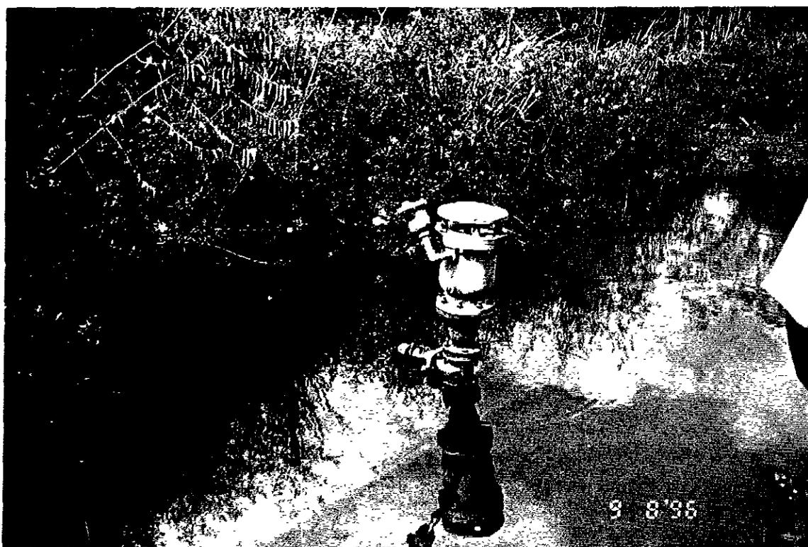
**FOTOGRAFÍA 4.** Aspecto de una válvula de admisión y expulsión de aire
