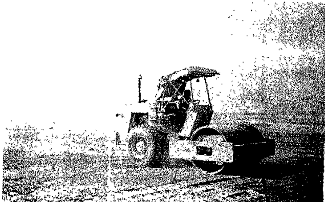
COMPACTACIÓN DEL MATERIAL DE CUBIERTA POR LA COMPACTADORA.
