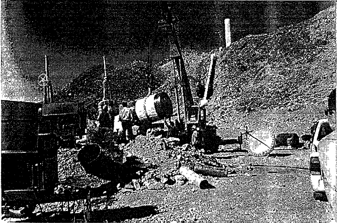
Figura 25. Izamiento del diablo por medio de una grúa para colocarlo dentro de la cámara lanza-diablos.
