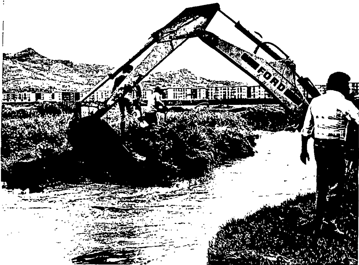
Obras de Dragado en el Municipio de Coacalco, Méx. 1991 - 1992.
