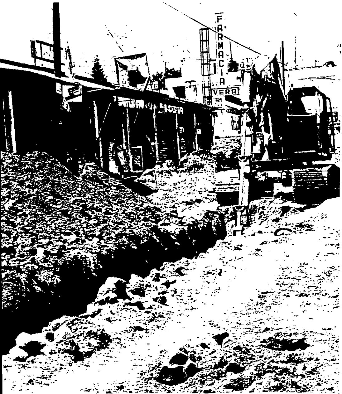
Pavimentación de la calle Richard O. Robín, Colonia Ampliación
