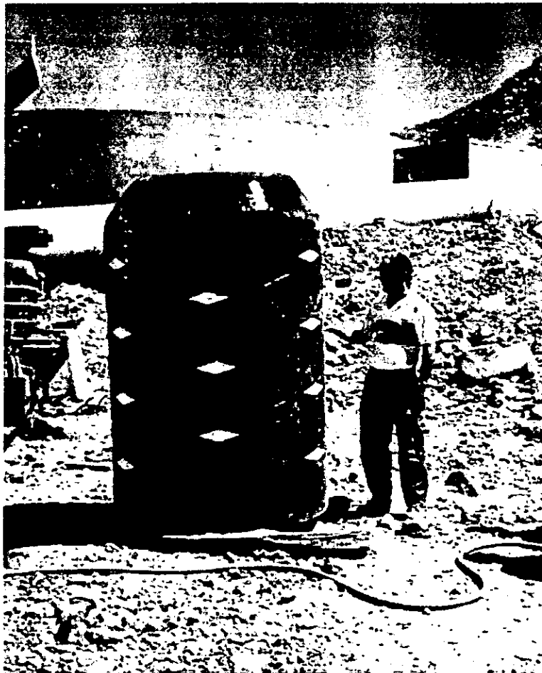
Fotografía 1.1. Diablo utilizado en la limpieza del Acueducto Río Colorado - Tijuana.
