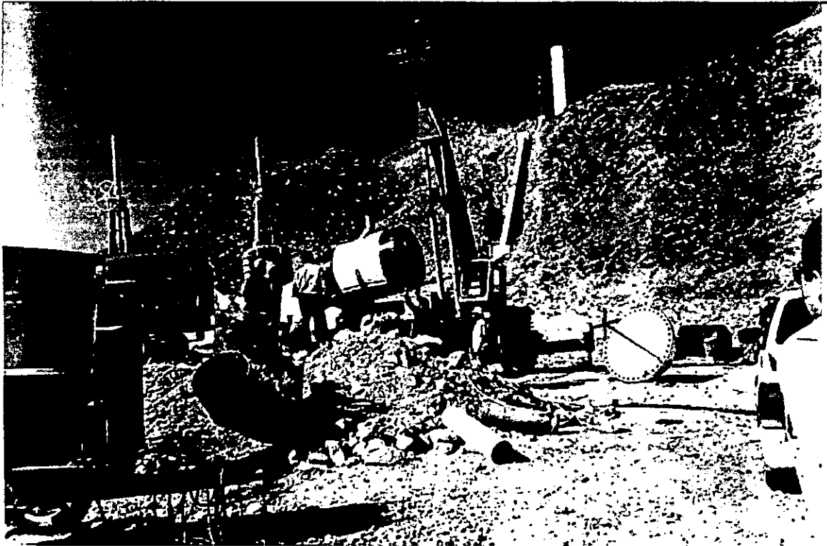
Fotografía 2.4. Maniobra de colocación del diablo en la esclusa con ayuda de la grúa.
