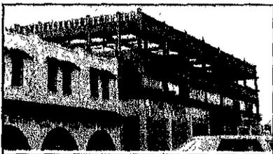
A partir de 1940 la construcción de edificios públicos de dos o más niveles se intensifica utilizando el sistema constructivo de concreto armado en todos sus elementos, denotándose a fines de la década la presencia del uso del block de concreto combinado con elementos de concreto armado.
