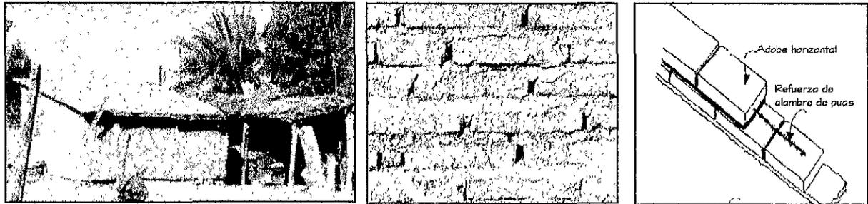
Fig. 136) Muro de adobe horizontal cuatrapeado
