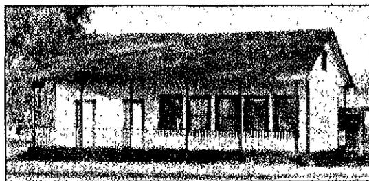
• Construcción de muros, pisos y techos inclinados de madera, con ventila en el ático de techos y desplante sobre el nivel de terreno natural, columnas de madera formando pasillo exterior, acabado aparente y pintura como acabado final.
