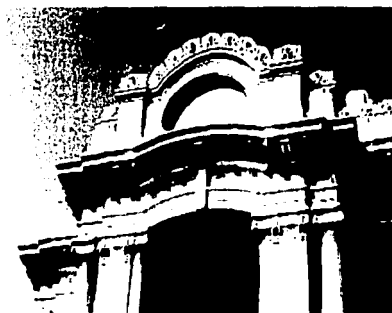
Ilustración 134 Detalle del pretil y capitel de las columnas
