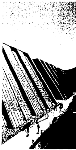
Ilustración 354 Comedor y dormitorios
