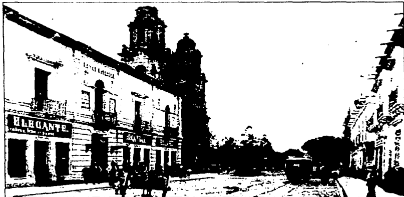
Foto 4.2.6.2(1) Hotel Argueta y el edificio de la calle Morazan.
