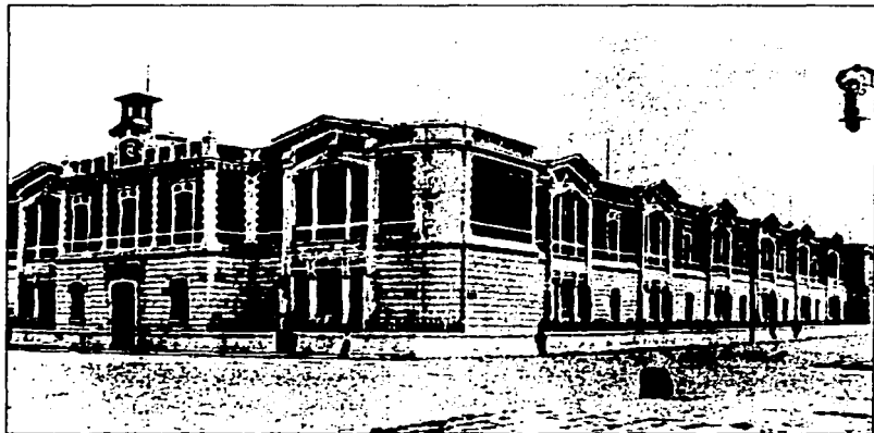
Foto 5.2.1.1 (95) Fachada de la escuela ubicada en calle Sur y avenida Poniente #14
