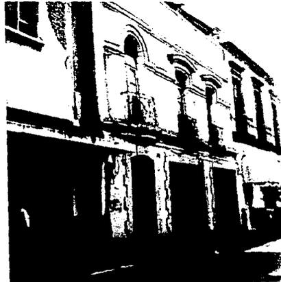
Foto 30. Ejemplo de las alteraciones sufridas en los vanos de la planta baja al convertir una vivienda en comercio.
