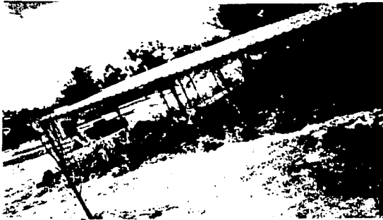
Foto 41. Techumbre que protege una de las pocas estructuras que fueron salvadas de su destrucción al lado de una alberca en el Balneario "Gaby".
