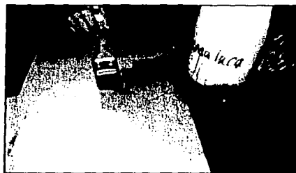
69.- El primer paso consistió en aplicar tres capas de goma laca.
