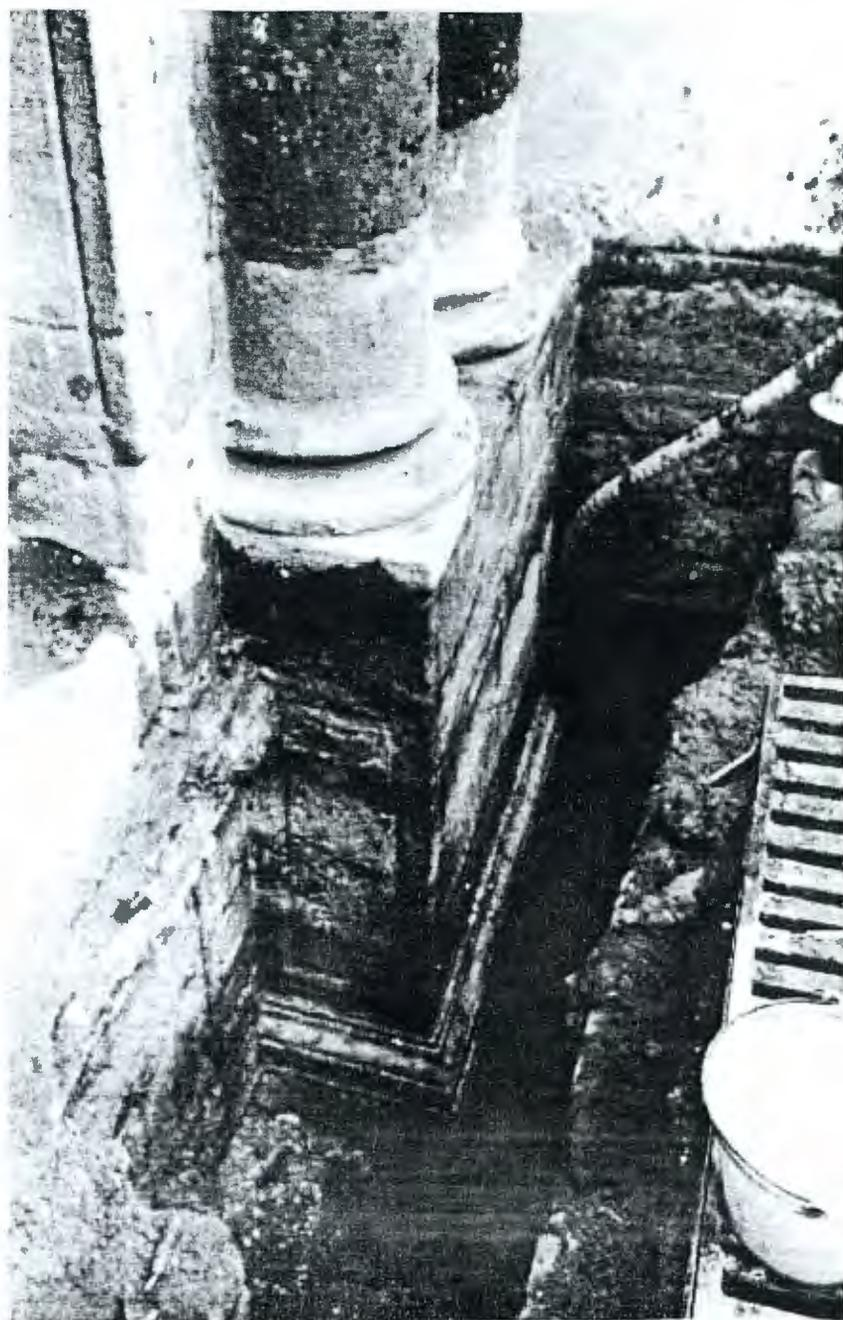
**FIGURA 14. VISTA DEL ACCESO PRINCIPAL DONDE SE CONSTATA EL HUNDIMIENTO DEL EDIFICIO.**
