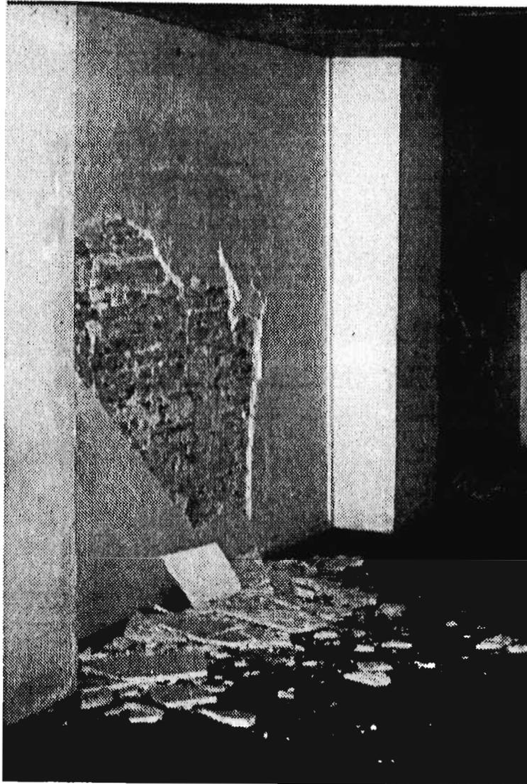
Fig 4.2      Agrictamientos en muros de mampostería a raíz del sismo de Copala (14 de septiembre de 1995) . Muro del nivel 6 en dirección longitudinal
