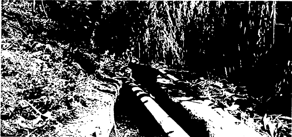
fig. 3.2 Línea de conducción apoyada sobre canal de riego.
