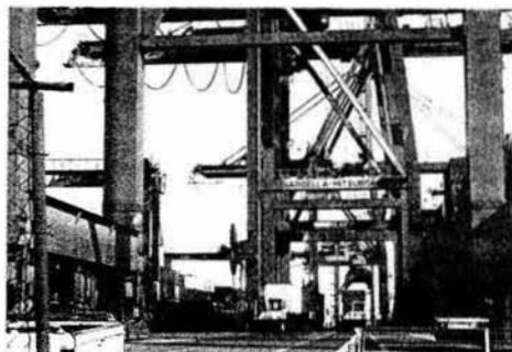
Fig. III.9 Grúa de Pórtico en ICAVE
