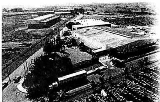
Figura I.12 Industrias en el Puerto
