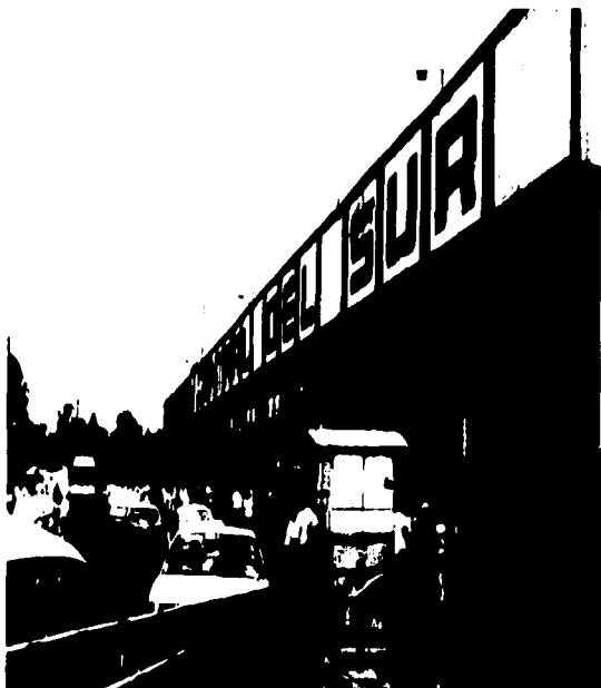
ACCESO A LA TERMINAL
