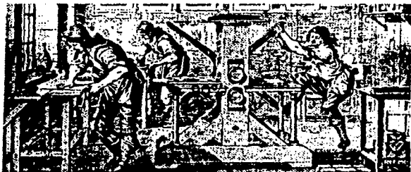
Funcionamiento de una imprenta primitiva. Grabado de Abraham Bosse.
