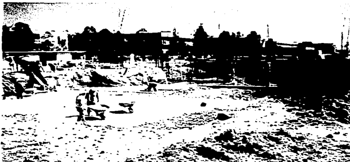
Fotografía 7.11 Colocación de Balastro y Plantilla de concreto en el Cajón del Edificio del Auditorio
