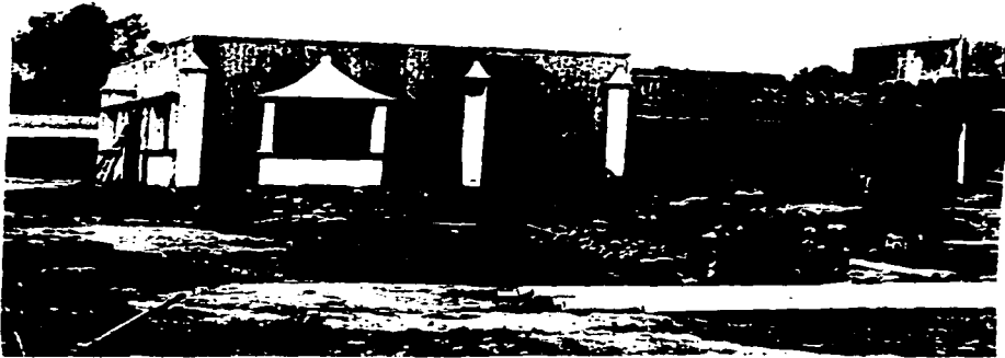
Acabados en acceso de la residencia de Tecamac, Edo. de Mexico
