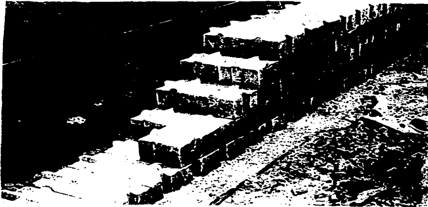
Traslape del machiembloque en la cimentación
