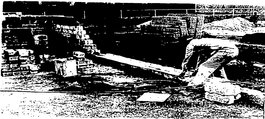
Impermeabilizando la cimentación
