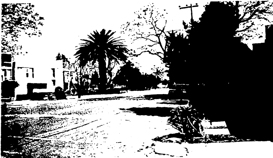
FOTO 8. Av. 5 Red de pavimentación cubierta en su totalidad.
