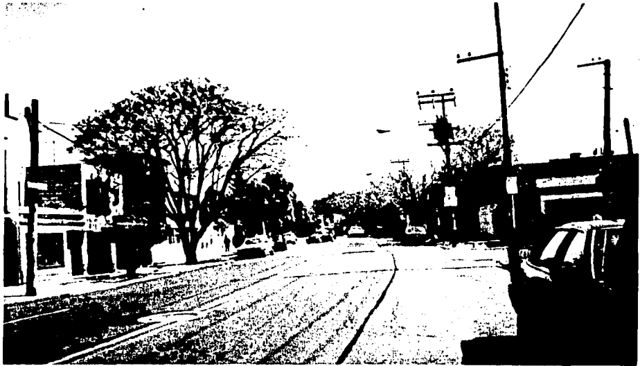
FOTO 10. Av. Castellanos Quinto, calle C, red de drenaje (coladeras), alumbrado público.
