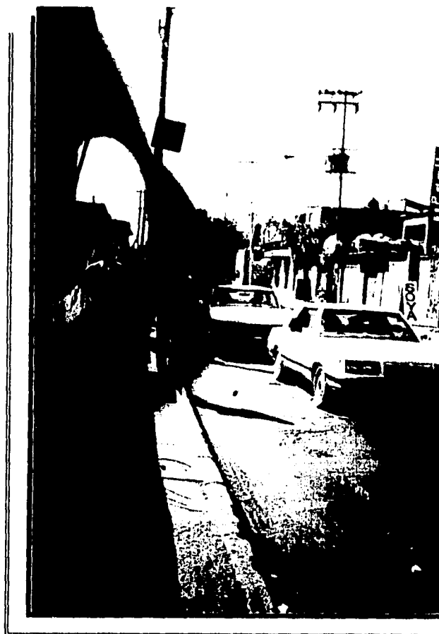
Vista de la Calle I. M. Altamirano, hacia aguas arriba del trazo del Colector Quetzalcóatl 1, a partir de la Av. Ernilla Iz.
