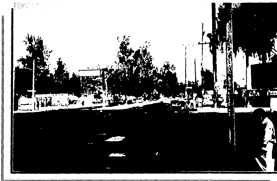
Cruce de la Calle I.M. Altamirano y la Av. Ermita Iztapalapa. Al fondo se observa el sitio de la continuación del trazo del Colector Quetzalcóatl 1, al lado derecho del camellón, dentro de la vialidad. A partir de este punto, el Colector trabaja solamente como Emisor.
