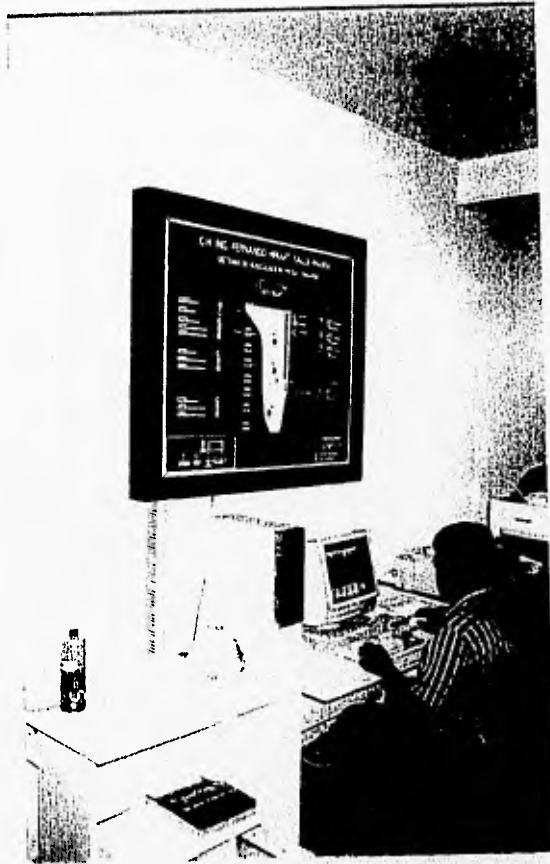
Fig 8.2 Tablero de señalización de alarmas y computadora central del sistema automatizado de medición.
