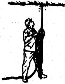
Perforadora rotativa de aire comprimido montada sobre compresor vertical (Empire).
