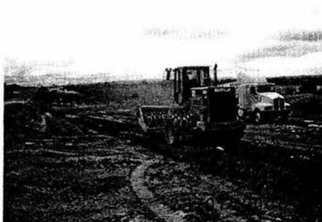
Imagen 1.2.4.-Compactación del terreno natural en el km 141+800
