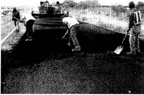
Imagen 3.37.- Colocado de carpeta asfáltica de forma manual.
