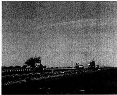
Imagen 1.2.28.- Compactación de carpeta asfáltica en la creación del cuerpo Nuevo en el Km. 141+500
