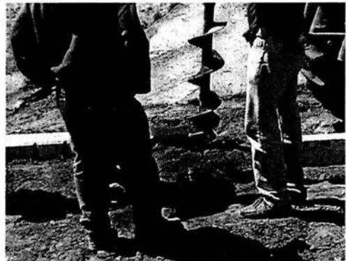
Imagen 2.4.- La broca que nos muestra esta imagen es utilizada debido a que el terreno es blando y permite hacer la excavación
