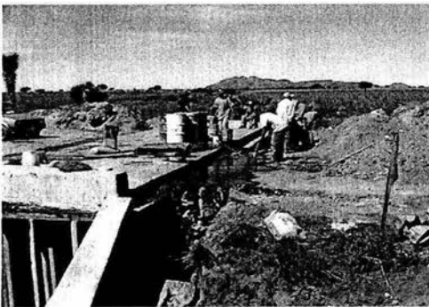
Imagen 1.2.17.- Aproches en el guardaganado del cuerpo existente en el Km 142+381.
