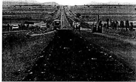
Imagen 1.20.-Riego de liga poreo en la franja del hombro izquierda de la ampliación del cuerpo existente en el Km. 144+700
