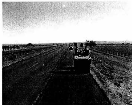
Imagen 1.2.24.-Compactación de carpeta asfáltica tendida en la franja izquierda de la creación del cuerpo nuevo en Km. 141+500
