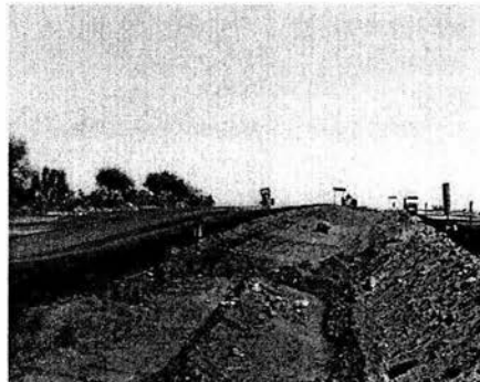
Imagen 1.2.18.- Arropes en la ampliación del cuerpo existente con ayuda de motoconformadora en el Km 141+800.
