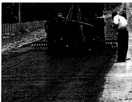
Imagen 3.26.- Riego de liga previo a la colocación de primer capa de base asfáltica.
