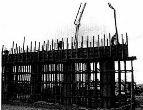
Imagen 3.13.- Colado de cabezal y bancos de apoyo de la pila numero 2
