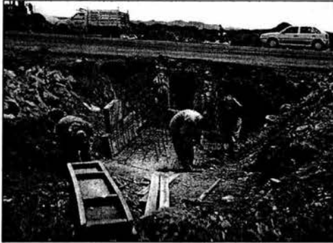
Imagen 1.2.11.- Trabajo de aplicación de alcantarillas en el cuerpo existente Km. 143+803.3
