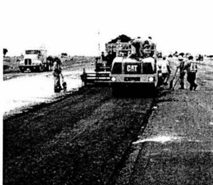
Imagen 1.2.10.-Colocación de primera capa de base negra en el kilómetro 140+200 del cuerpo nuevo.
