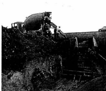
Imagen 1.2.14.-Colado de zapata del guarda ganado ubicado en el Km. 142+386, en la ampliación del cuerpo nuevo.
