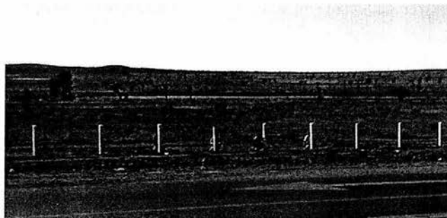
Imagen 2.8.- Cabe mencionar que los postes son prefabricados con concreto armado de resistencia f'c = 150 \text{ kg/cm}^2
