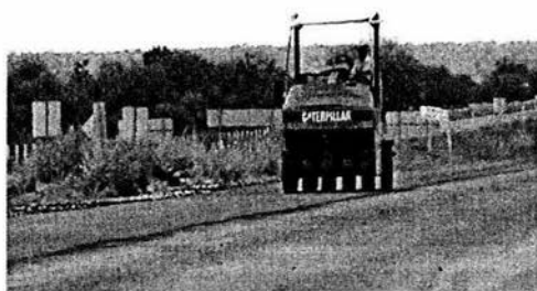
Imagen 3.33.- Compactador neumático en segunda capa de base asfáltica franja izquierda de el km 133+500. Cuatro cerradas
