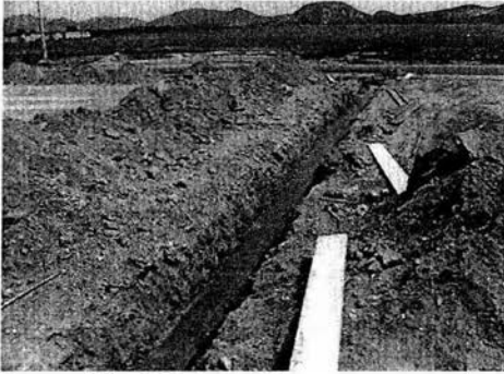
Imagen 3.9.- Colado de dala para muro en el desplante
