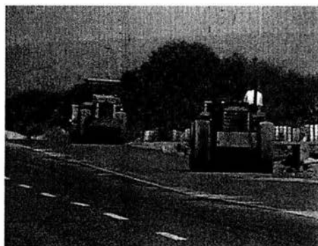
Imagen 3.24.- Compactación de la capa subrasnte en el km 134+600
