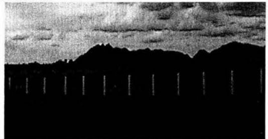
Imagen 2.7.- Postes listos para recibir el alambre, para cercar el derecho de vía.
