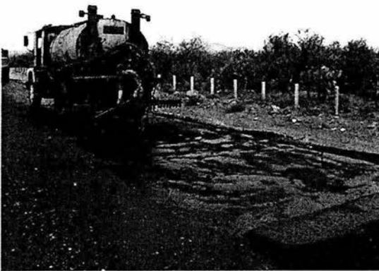
Imagen 3.30.- Riego de ligaprevio al tendido de la segunda capa del km 130+590 al km 131+340.
