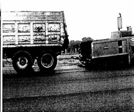
Imagen 3.32.- Llegada de material asfáltico en camiones de volteo de 14 m 3 , el material es vertido al equipo pavimentador.
