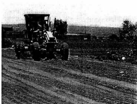
Imagen 3.4.- Conformación de la capa subyacente del km 139+610 al 139+760; lateral izquierda
