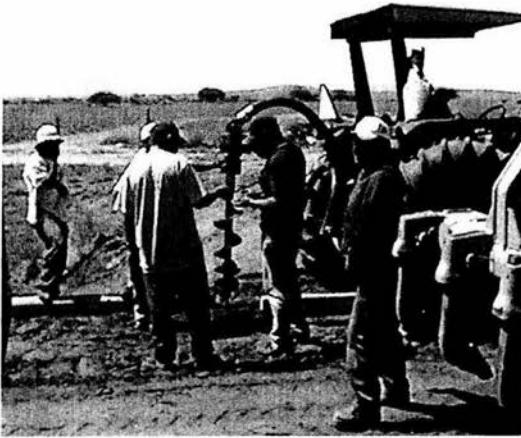
Imagen 2.5.- El tractor agrícola que ilustra la imagen, no solo ayuda a la excavación sino a trasladar equipo menor y suministros como: agua, cemento, agregados pétreos, etc.
