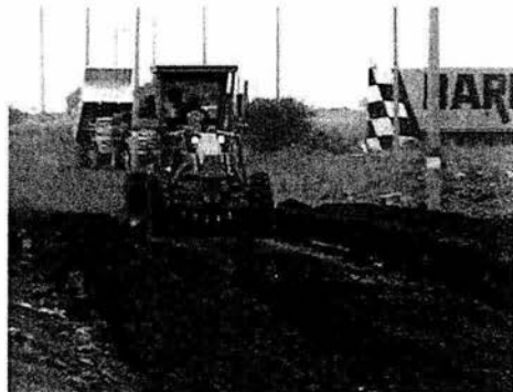
Imagen 3.2.- Conformación del terreno natural en el km 139+220 calle lateral derecha.
