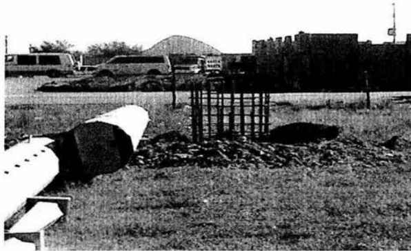
Imagen 3.19.- Armado de la cimentación para la reubicación de las líneas de CFE. El poste de acero que se encuentra tendido, tiene una longitud de 25 m.
