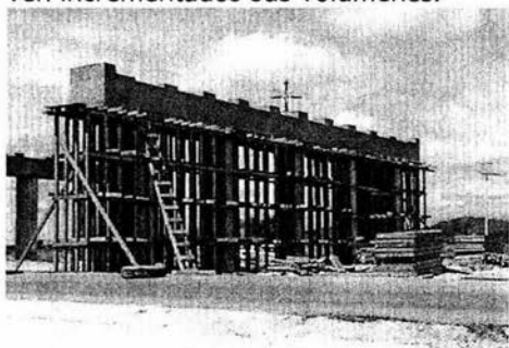
Imagen 3.15.- Vista del cabezal y bancos de apoyo en la pila número 2
