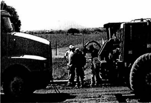
Imagen 2.3.- Excavación de terreno natural para la colocación de postes
