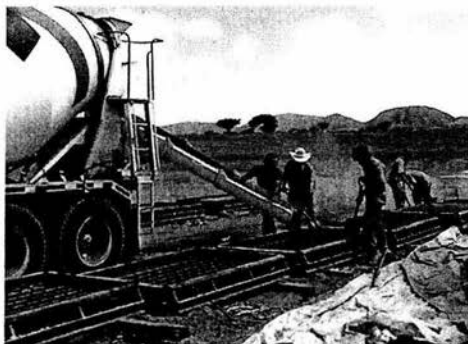
Imagen 3.5.- Colado de las escamas de concreto para los muros estabilizados mecánicamente
