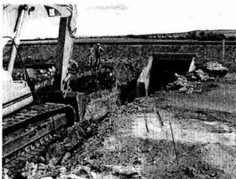
Imagen 1.2.13.- Excavación del cuerpo existente para preparar el despalme de la obra de drenaje y guardaganado en la ampliación del cuerpo existente. Km. 142+386.
