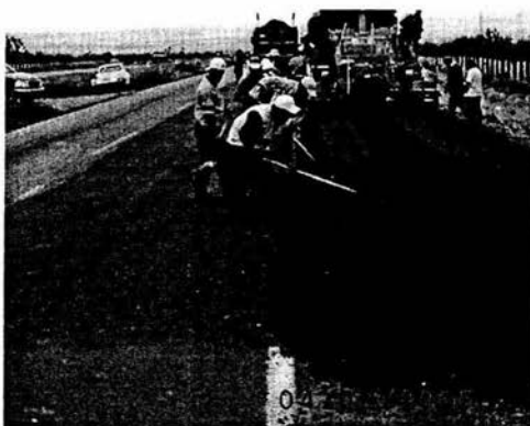
Imagen 3.31.-Tendido de segunda capa de base asfáltica sobre la ampliación del km 127+200 al km 128+000.
