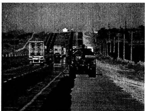
Imagen 3.25.- Riego de impregnación de la subrasante del km 135+600 al km 136+100
