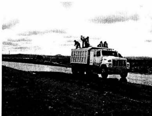
Imagen 1.2.9.-Trabajos de poreo en riego de liga en el kilómetro 144+100 en el cuerpo nuevo.
