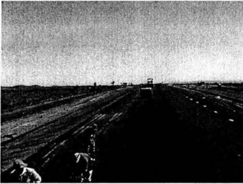
Imagen 1.2.21.- Tendido y compactado de base negra en la franja central del cuerpo existente ubicado en el Km. 144+000.
