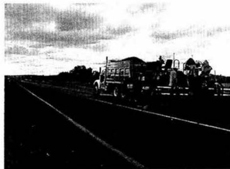
Imagen 3.36.-Tendido de carpeta asfáltica en el km 134+500 en la franja izquierda de un ancho de 3.5 m
