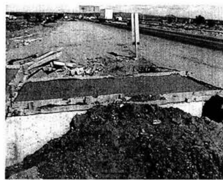
Imagen 1.2.12.- Losa colada en la ampliación de la alcantarilla Km. 140+618.
