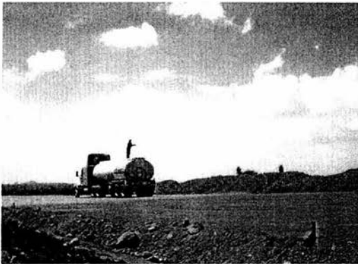
Imagen 1.2.8.- Incorporación de humedad por medio de una pipa de 1800 lt de capacidad.
