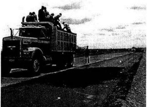
Imagen 3.27.-Poreo a riego de liga previo al tendido de base asfáltica en el km 138+367.5
