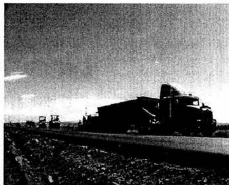
Imagen 1.2.26.- Tendido de carpeta asfáltica en la rehabilitación del cuerpo existente, Km. 142
