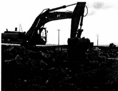
Imagen 3.8.- Demolición de pavimento de concreto hidráulico en lateral izquierda del km 139+400 al 139+840
