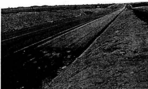
Imagen 1.2.23.- Riego de liga en la franja izquierda del cuerpo nuevo, preparación para tendido de carpeta asfáltica, en el Km. 143+000.
