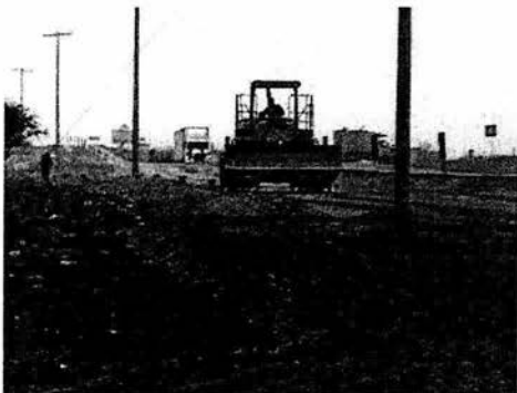
Imagen 3.1.- Compactación del terraplen en el km 139+060 calle lateral derecha.
