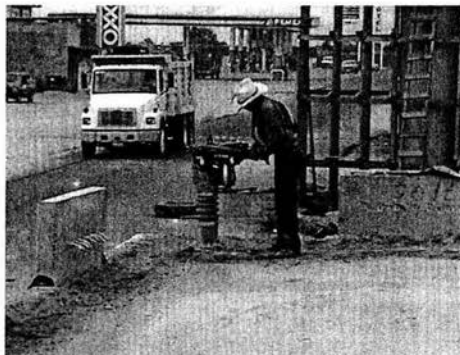
Imagen 3.16.- Compactación del terraplen en la zonas cercanas a los muros con equipo menor.
