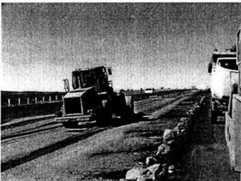
Imagen 1.2.27.-Trabajo de terracerías en el carril de desaceleración en el retorno hacia Zacatecas en el Km. 145+000
