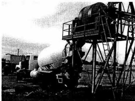
Imagen 3.6.- Fabricación de concreto f'c = 350 kg/cm 2 para traveses de longitud de 25.6 metros.
