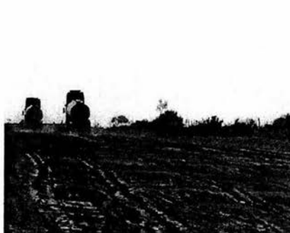
Imagen 1.2.5.- Suministro de humedad en el terreno natural en el kilómetro 141+200
