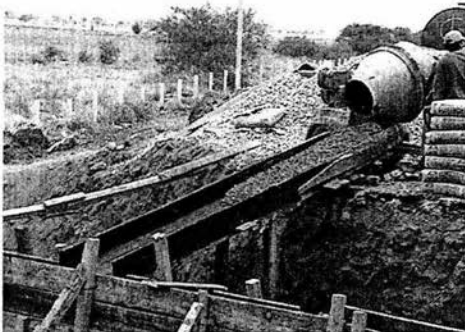
Imagen 3.21.-Colado de estribo de la obra de drenaje ubicada en el km 136+486.9
