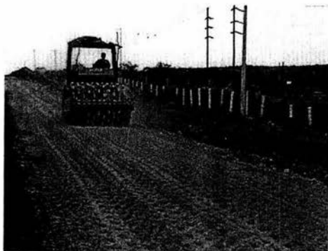
Imagen 3.23.-Compactador pata de cabra compactado la capa subyacente en el km 137+650
