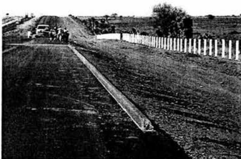
Imagen 1.2.25.- Colado de bordillos en la rehabilitación del cuerpo existente en el Km. 142+000
