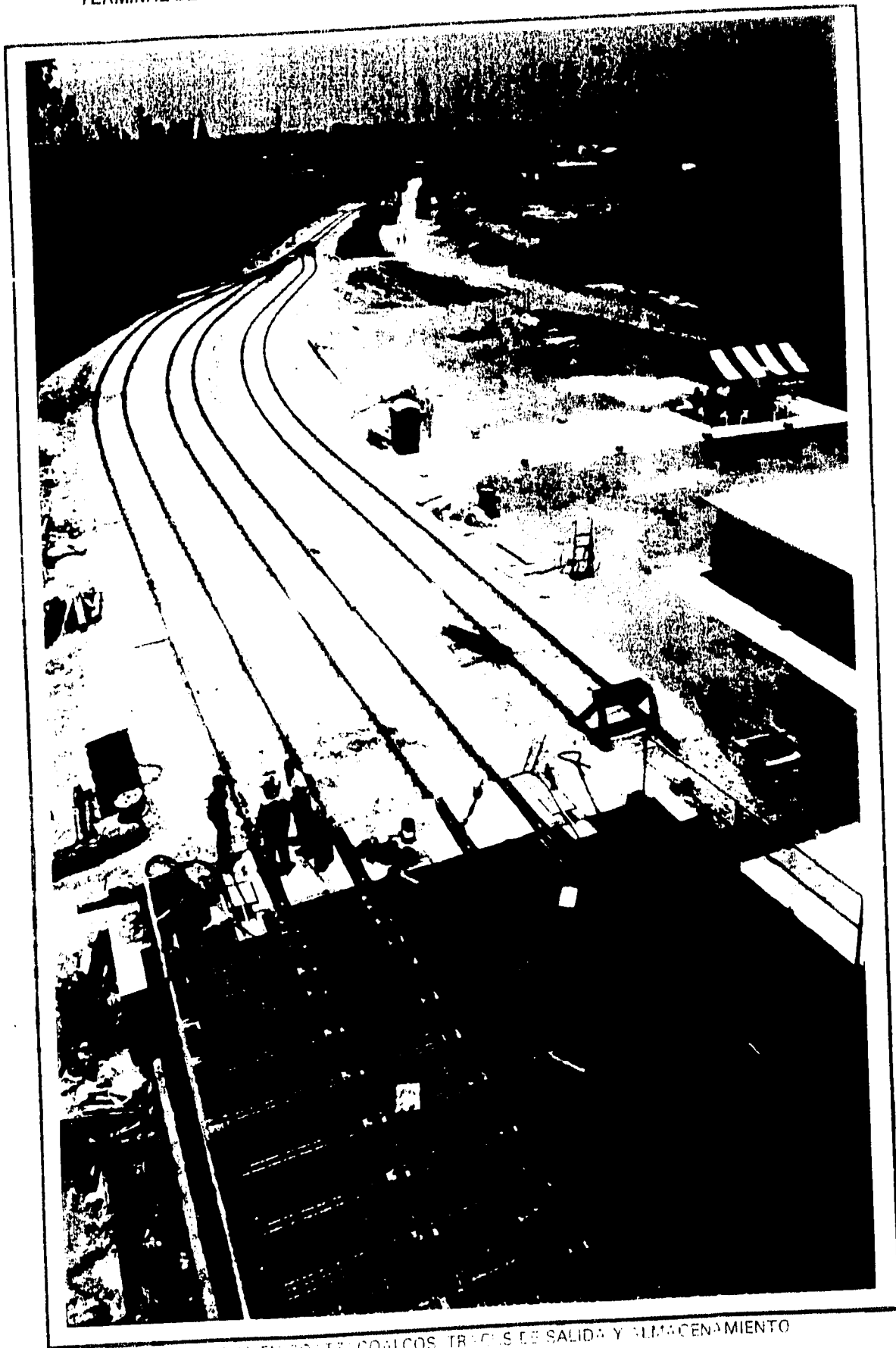
TERMINAL DE COATZACOALCOS, TRACKS DE SALIDA Y ALMACENAMIENTO
