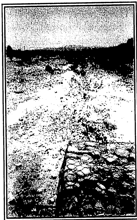
Fotografía 24. Gaviones construidos en la planicie aluvial para evitar daños a la carretera.
