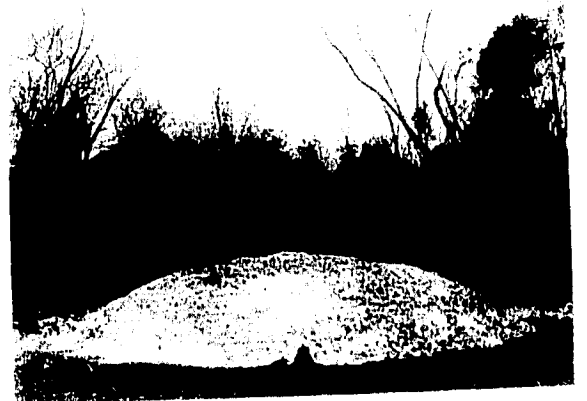
Figura 13. Proceso de quema de la cal en horno abierto. Tomado por Morris en 1931.
