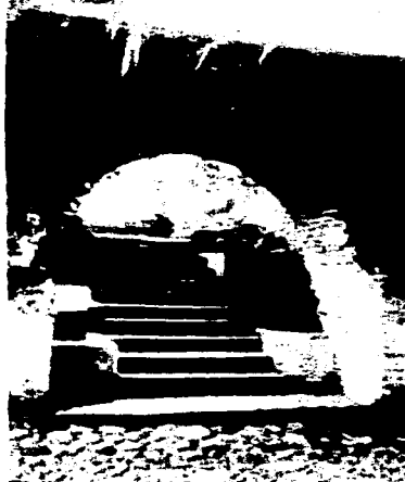
26. TOMA 6 acceso a la terraza jardinada acceso del patio de maniobras
