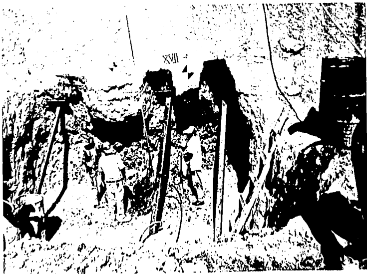
COLOCACION DE PUNTALES PARA LA PROTECCION DEL TALUD VERTICAL.
