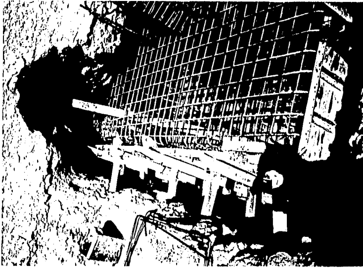
DISTRIBUCION DE ACERO DE UNA ZAPATA CUADRADA
