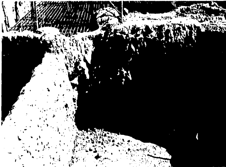
CORTE REQUERIDO PARA ALOJAR ZAPATAS.
