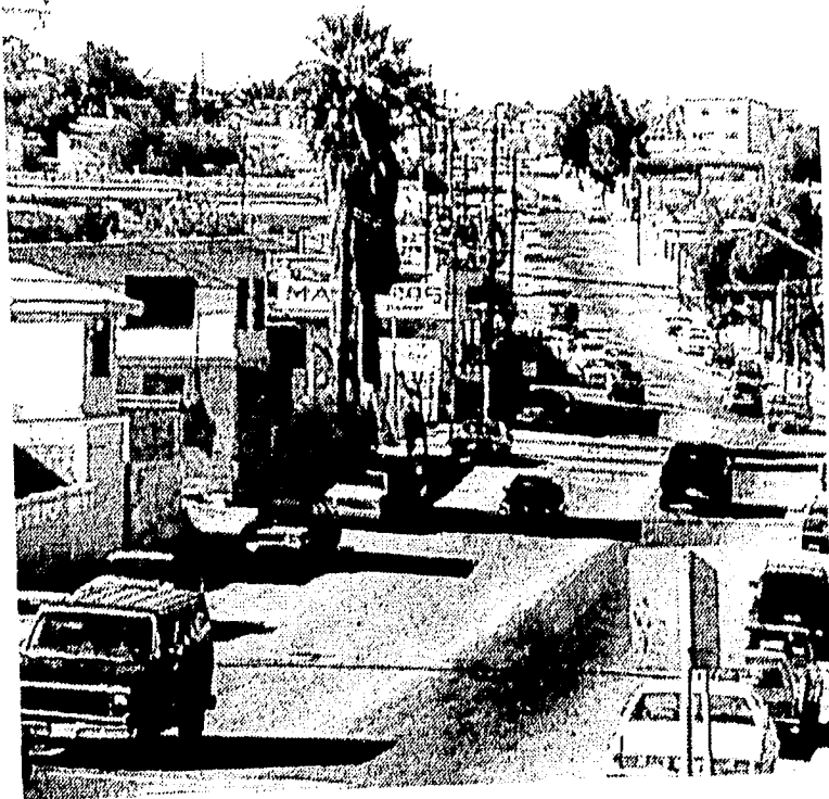
En la presente fotografia se puede observar otra vista de la calle donde se aplico el estudio, ya restablecido el trafico vehicular (foto CEMEX).
