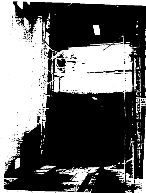
ESTRUCTURA METALICA COLUMNA METALICA NUEVA PARA MARCO PARALELO AL EJE DE DOBLE ALTURA
