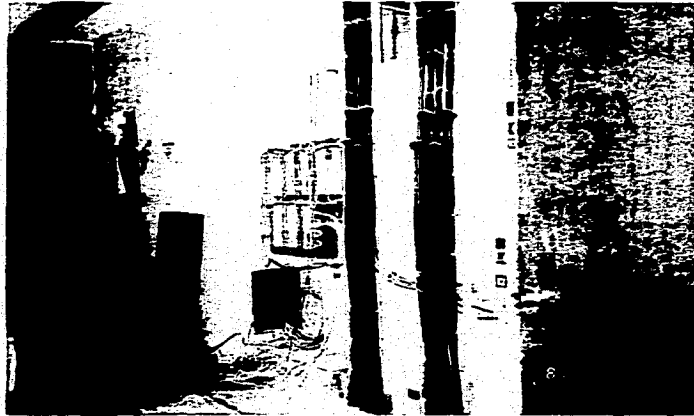
INSTALACIONES CABLEADO COLOCADO EN TUBO DE LINEA ALTERNIA TABLEROS E INTERRUPTORES NUEVOS INSTALADOS CONEXIONES A TABLEROS REALIZADA
