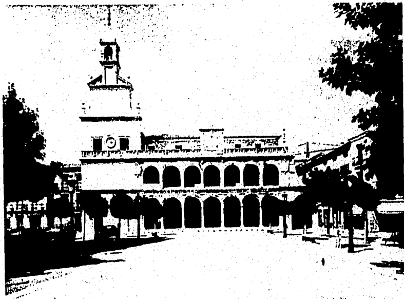
Ayuntamiento de San Clemente, España. Fachada.
