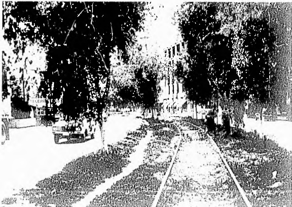
Av. Periférico - del Ferrocarril.
