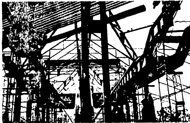
Fotografía No. 11.- Colocación de la estructura metálica para la techumbre.
