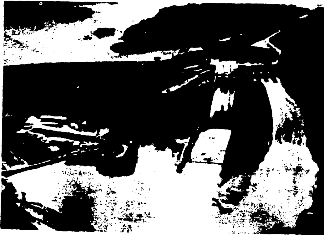
Figura 1.1 Vertedor Presa Netzahualcoyotl, Chis. (Malpaso). En el tanque amortiguador(lado derecho) se está presentando un salto hidráulico.
