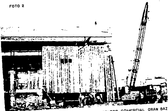
MONTAJE DE VIGAS T-T EN LA FACHADA DEL CENTRO COMERCIAL GRAN BAZAR
