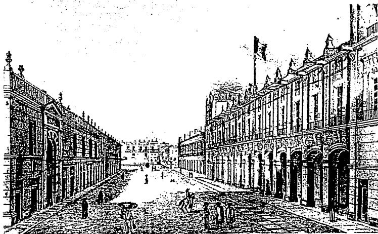
PORTAL DEL AYUNTAMIENTO.
