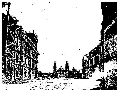
LA DEMOLICION DEL PORTAL DE LAS FLORES.
