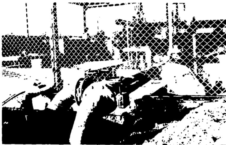
Armado Total del Sistema de Filtración y Resguardo del Equipo . También se puede Observar el montaje de las Llaves de Paso Principales de la Red de Distribución y la Tubería de salida del Retrolavado.
