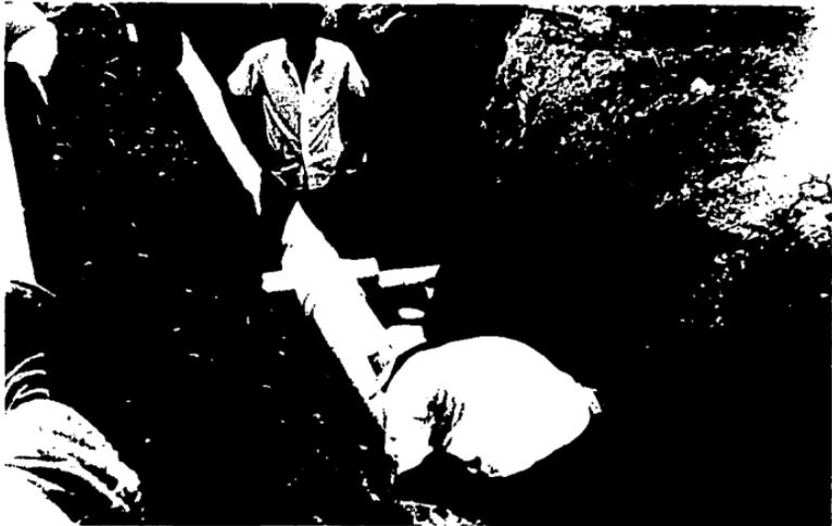
Colocación de un crucero en la Tubería Principal con una Reducción
