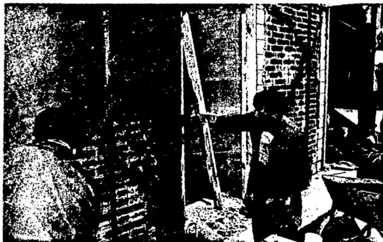
*Figura 3.17 Aplicación del Mortero de Recubrimiento en los Muros de Mampostería del NI*
