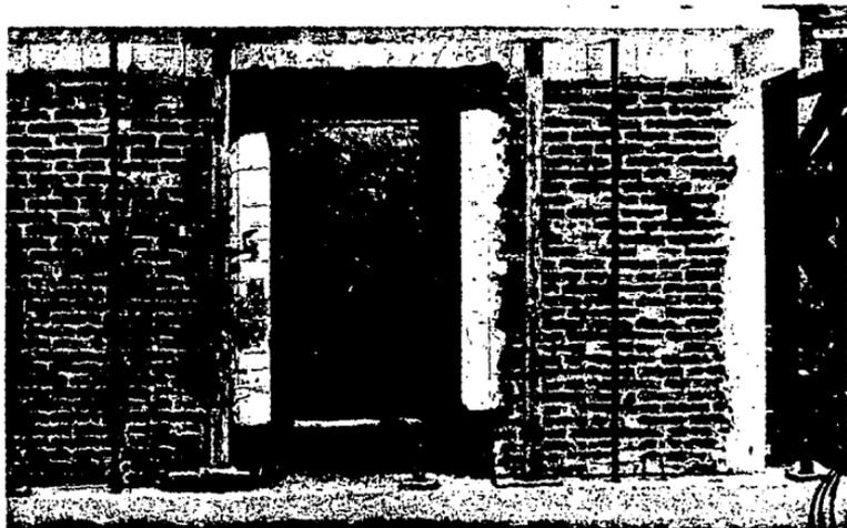
*Figura 3.8 Vista de la Cara Norte del NI Antes de Colocar Concreto Fresco en los Castillos*
