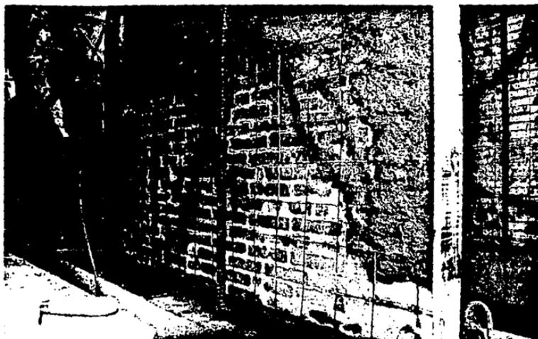
*Figura 3.16 Saturación de los Muros de Mampostería del NI*
