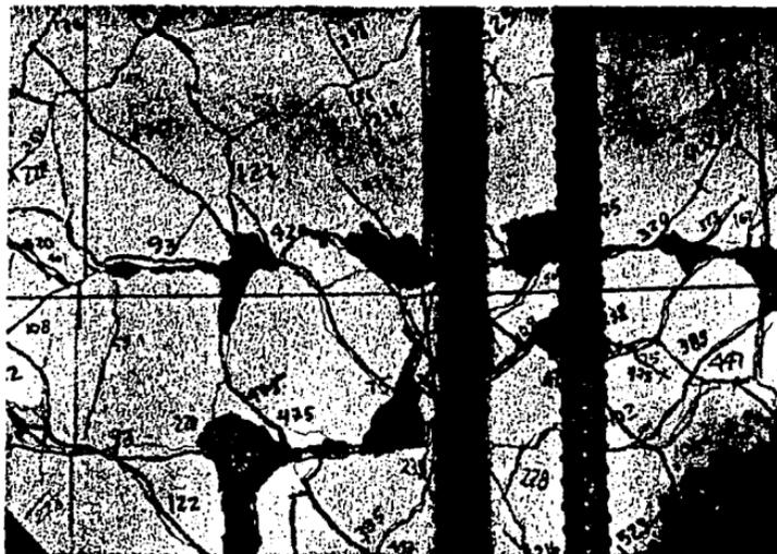
Figura 4.33 Fisuramiento en la Cara Exterior del MSPO del NI
