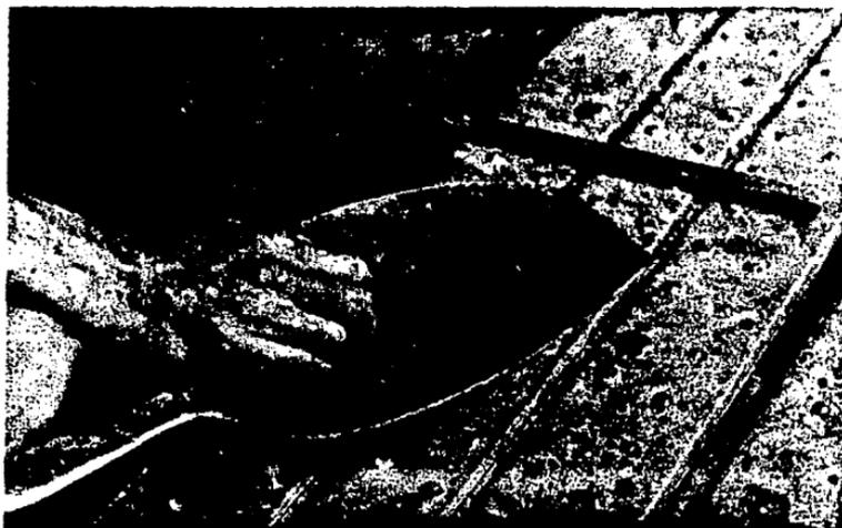
*Figura 3.10 Concreto Seco Utilizado para Completar la Reparación de los Castillos Interiores*
