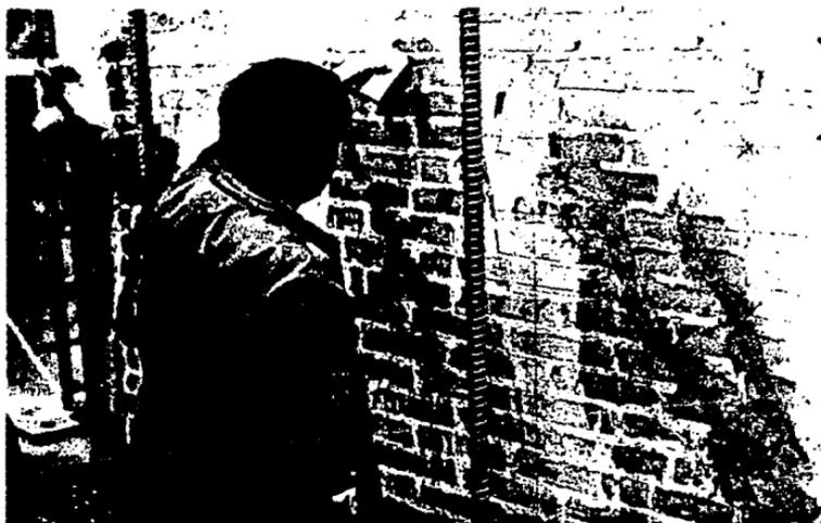
*Figura 3.13 Maniobra de "Rajuelo" en los Muros de Mampostería del N1*
