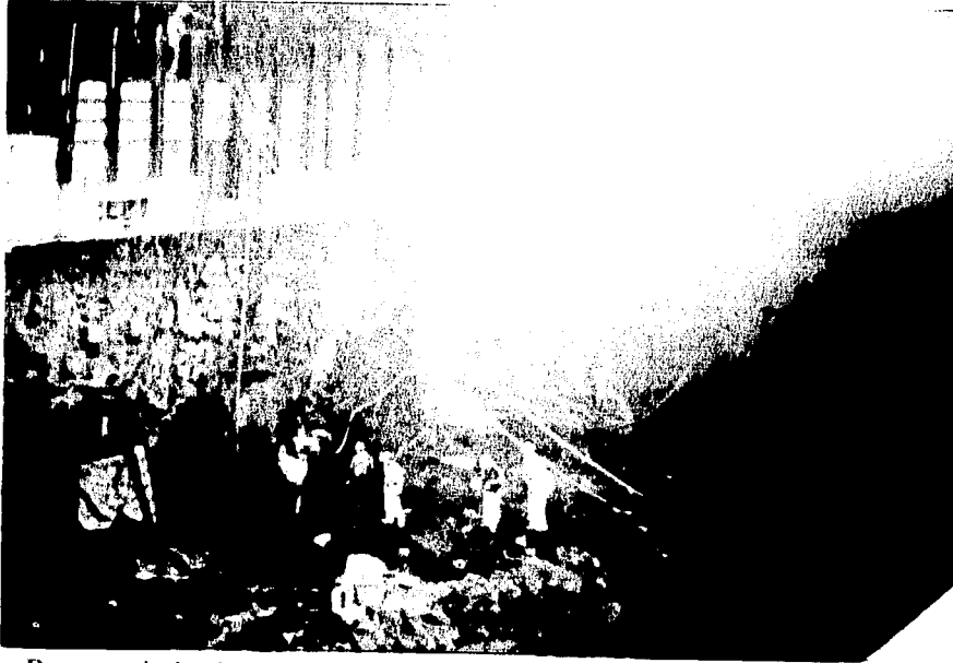
Banqueo de la elev 967.50 a la elev 962.00. Obsérvense los "noneles" o retardadores ( cables color amarillo y color naranja ) y el explosivo "Tovex" 700 ( cartuchos color blanco ).
