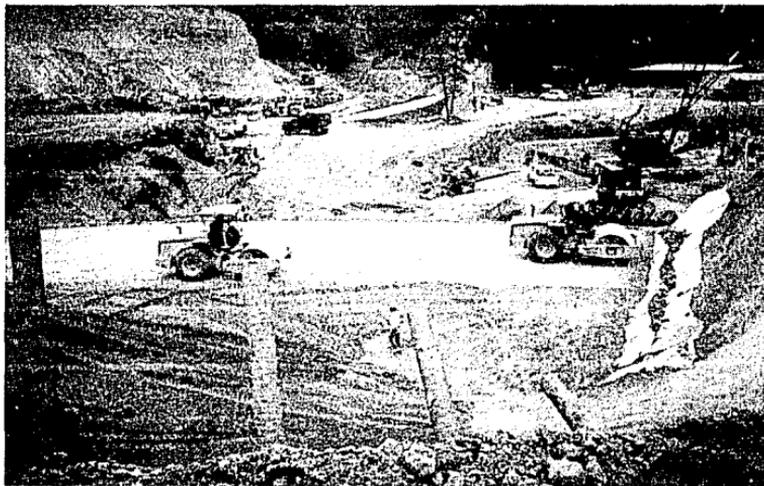
**Fotografías .- Colocación y tendido del geotextil .Protección de relleno en para construcción de una vialidad en Interlomas , Edo. de Méx.**
