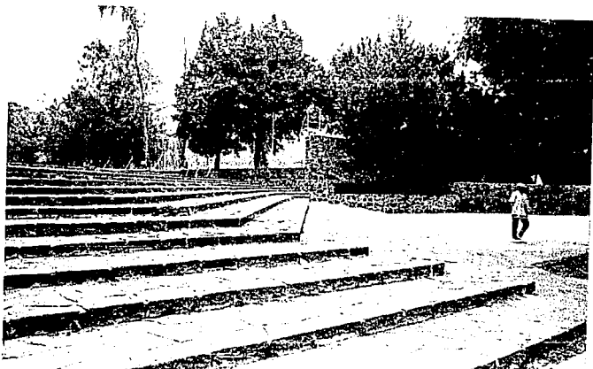
Vista de la escalinata que comunica los frontones con el camino C3-27 verde. Importante ajustar el nivel con rampa de 6-10% de pen--- F 3B diente.
