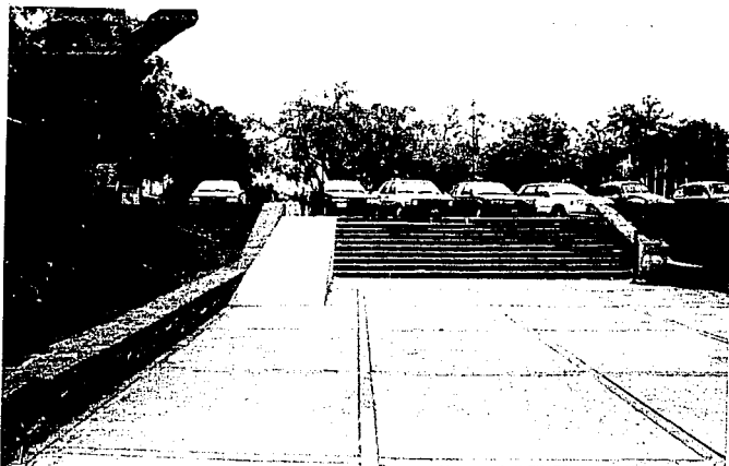
Vista hacia el estacionamiento de guardería/alberca. Rampa existente, ruta 1 de bicicletas, ajustar pendiente (6-10%) y estacionamiento. C3-Z1 F 1A
