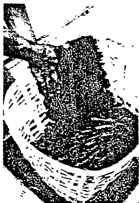
Figura 5. Luego se recubre con mortero el lado interior.
