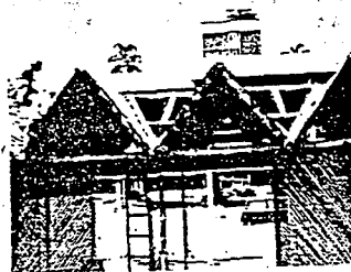
Fig. A.4.17. Construcción del sobretecho.
