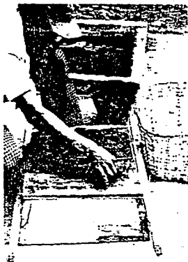
Figura . Sobre la superficie de madera, nivelada, se aplica aceite quemado con un trapo o en su lugar parafina
