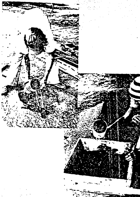
Figura ... Para medir el agua se puede emplear también un tarro de galletas, diferente al utilizado para medir el cemento y la arena.
