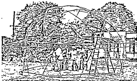
Cúpula tensegrity de bambú, Calcuta, 1961. Estudio para un refugio barato aprovechando materiales y facilidades locales.
