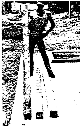
Figura 5.- Las formeleas pueden quitarse dos días después de hundidos los postes. Estos deben humedecerse dos veces al día durante una semana para lograr un buen curado. Los postes sólo pueden utilizarse 4 semanas después de hundidos.
