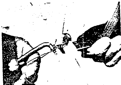
Figura 1.8.1.6.- Torsión del alambre con el gancho.
