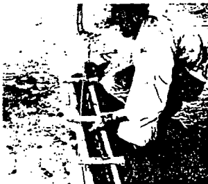
Figura 2.- Las perforaciones de los postes se hacen dejando varillas de acero o de bambú de 1/4 de pulgada, empapadas con aceite quemado, que luego se sacan 8 a 10 horas de hundidos los postes.
