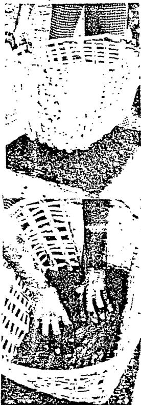
Figura 4. La capa de mortero se presiona con los dedos sobre la anterior.
