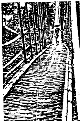
Figura 14. Puente tirantado de bambú originario de Java y Borneo. Nótese la limpieza del acabado de la estructura y del piso.
