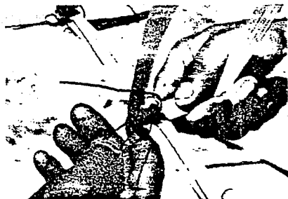
Figura 1. Doblado diagonal de los extremos del alambre.
