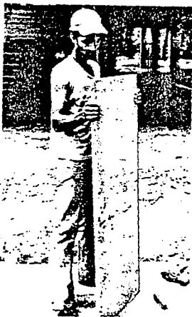
Figura 3. Las plaquetas deben hacerse de dimensiones apropiadas para facilitar su transporte.
