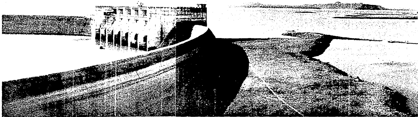
Fotos 9 y 10. Panorámica de la presa Miguel Hidalgo.
