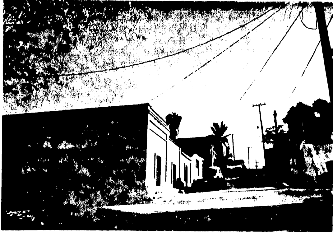
CALLE SECUNDARIA CASCO URBANO
